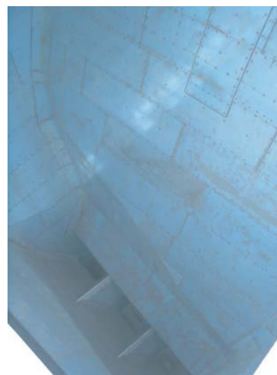
Применение футеровки TIVAR BlueLine для стенок бункера угля.
