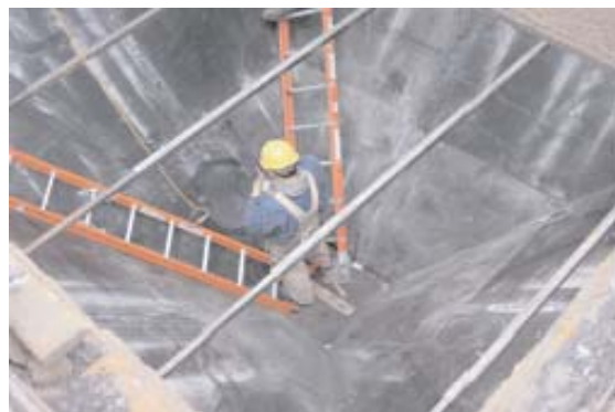
Сервис-инженеры завершают установку и осмотр подготовленной к установке футеровки TIVAR® 88 w/BurnGuard™.
