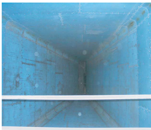
Применение футеровки TIVAR BlueLine для покрытия, бункера.
