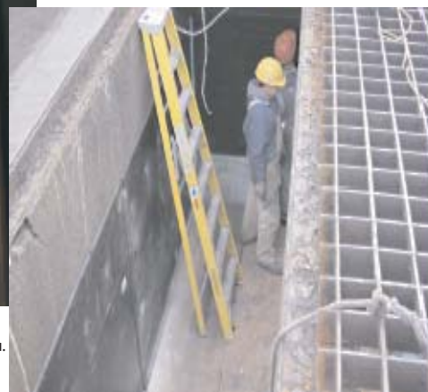
Сервис-инженеры обращают особое внимание на детали во время установки футеровки TIVAR® 88 w/BurnGuard™ liner, чтобы быть уверенными, что футеровка правильно установлена и обеспечит бесперебойное использование в течение длительного периода времени.
